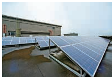
屋頂設置太陽能板
