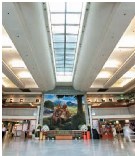
天花板採光罩可讓陽光自然照射進室內。
